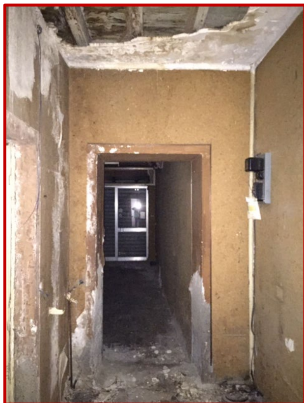
interno – piano terra locale ad uso commerciale
