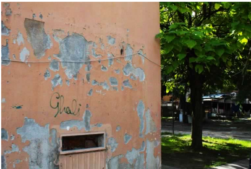
Muri esterni di una “stecca”
